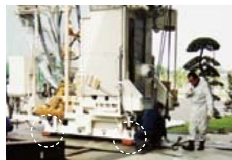
重量物の搬送には床面保護のため、鉄板等による養生を行います。
