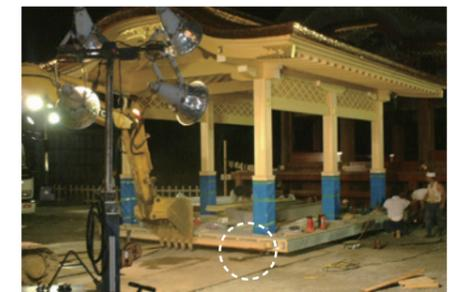
壊れやすい建造物の移動にもスピードローラーが万全のサポート。
